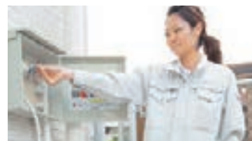
供給ボックスは2箇所を設置されています
